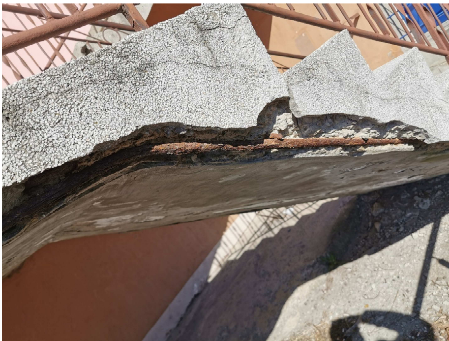
Fot. 5 Ubytki betonu, widoczna korozja stali zbrojeniowej
