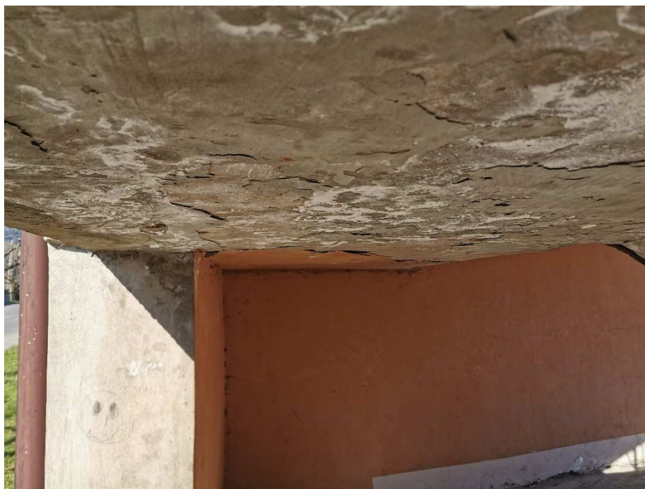
Fot. 7 Widoczne odspojenia zewnętrznej warstwy tynku.
