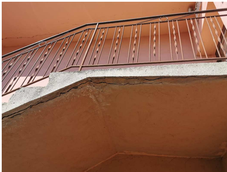
Fot. 8 Widoczne odspojenia zewnętrznej warstwy tynku. Widoczne oznaki zniszczenia betonu. Balustrada w dobrym stanie technicznym
