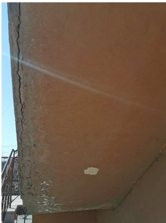
Fot. 9 Widoczne odspojenia zewnętrznej warstwy tynku. Widoczne oznaki zniszczenia betonu. Balustrada w dobrym stanie technicznym
