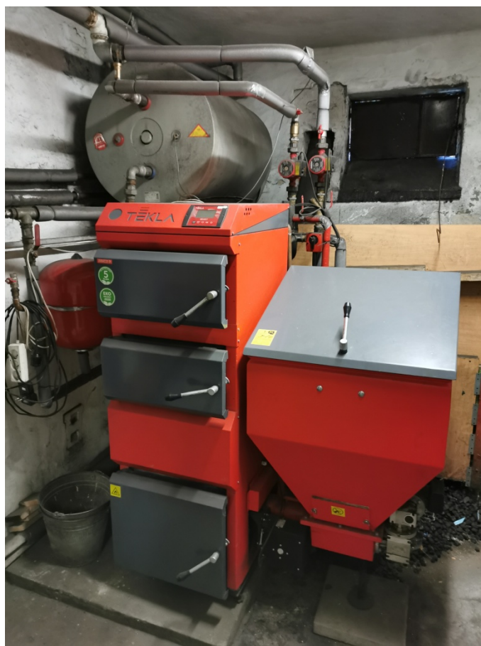
Fot. 1. Istniejące źródło ciepła i zasobnik c.w.u.
