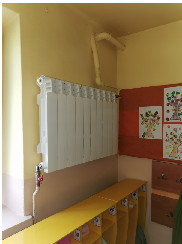
Fot. 3. Istniejący grzejnik aluminiowy żeberkowy w szatni z fragmentem instalacji z rur stalowych i miedzianych
