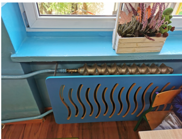
Fot. 5. Istniejący grzejnik żeliwny żeberkowy z osłoną w pokoju zajęć
