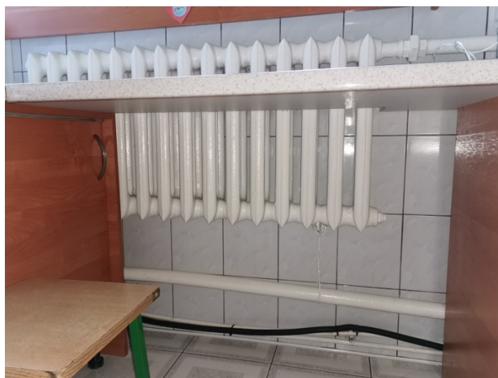
Fot. 2. Istniejący grzejnik żeliwny żeberkowy w kuchni
