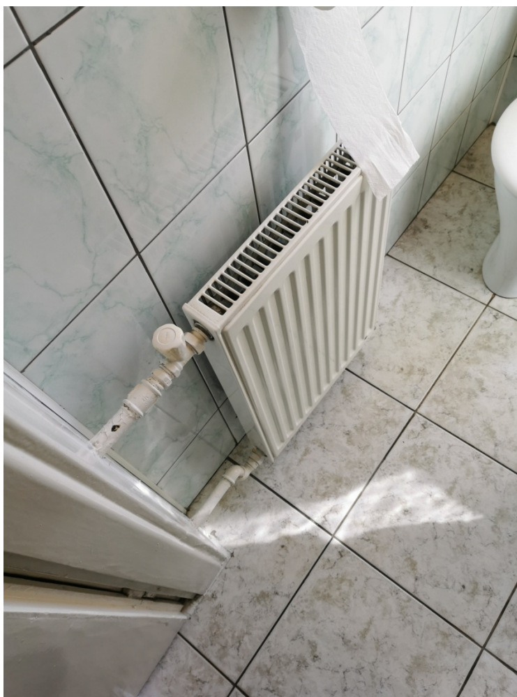
Fot. 4. Istniejący grzejnik stalowy płytowy w WC
