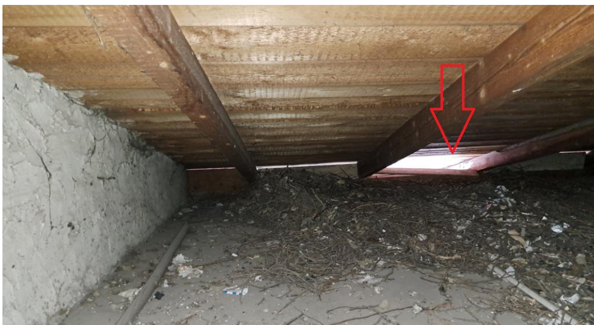
Ryc. 6. Materiał gniazdowy zgromadzony na strychu. Strzałką zaznaczono aktualny wlot w miejscu obluzowanej deski.
