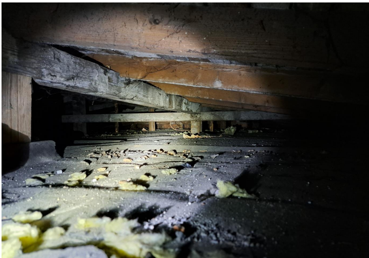
Ryc. 6. Przestrzeń strychowa. Na pierwszym planie zniszczone przez kunę domową ocieplenie.
