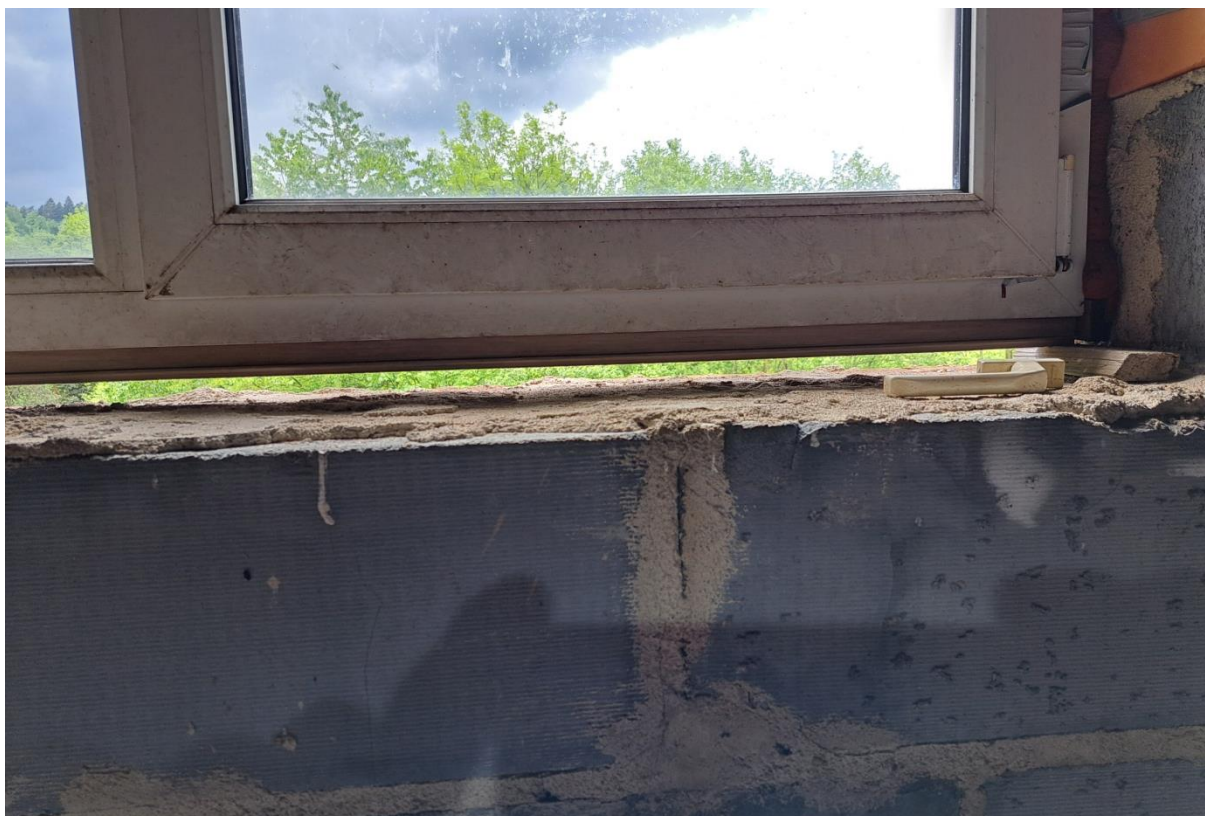
Ryc. 15. Szczeliny pod stolarką okienną.
