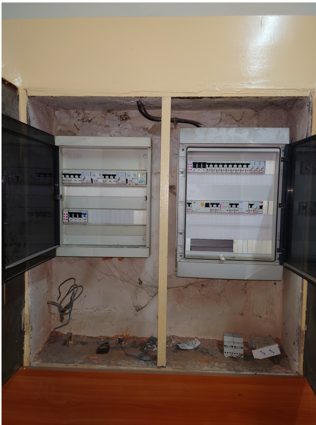
Ilustracja 1: Istniejąca tablica bezpiecznikowa do wymiany i rozbudowy o wyposażenie tablicy wewnętrznej PV
