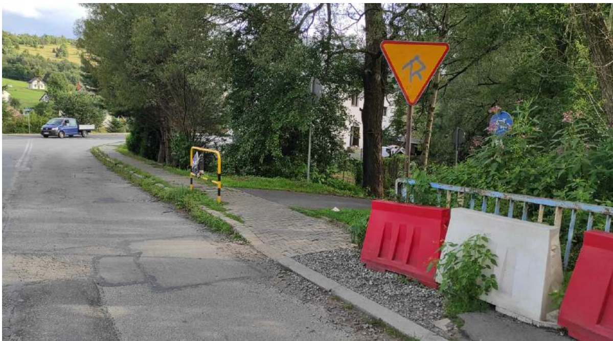
Rys. 24. Brak wjazdu z jezdni na istniejącą drogę dla rowerów, ze względu na wysoki krawężnik. Rejonie stacji kolejowej Rajcza.
