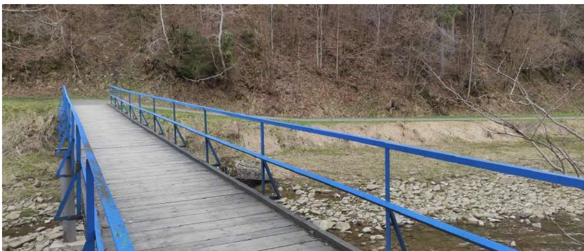
Rys. 29. Istniejąca kładka na rzece Woda Ujsolska w rejonie ul. Wspólnej. W dalszej perspektywie, obiekt należy poszerzyć do szer. 4 m. Ujszoły.
