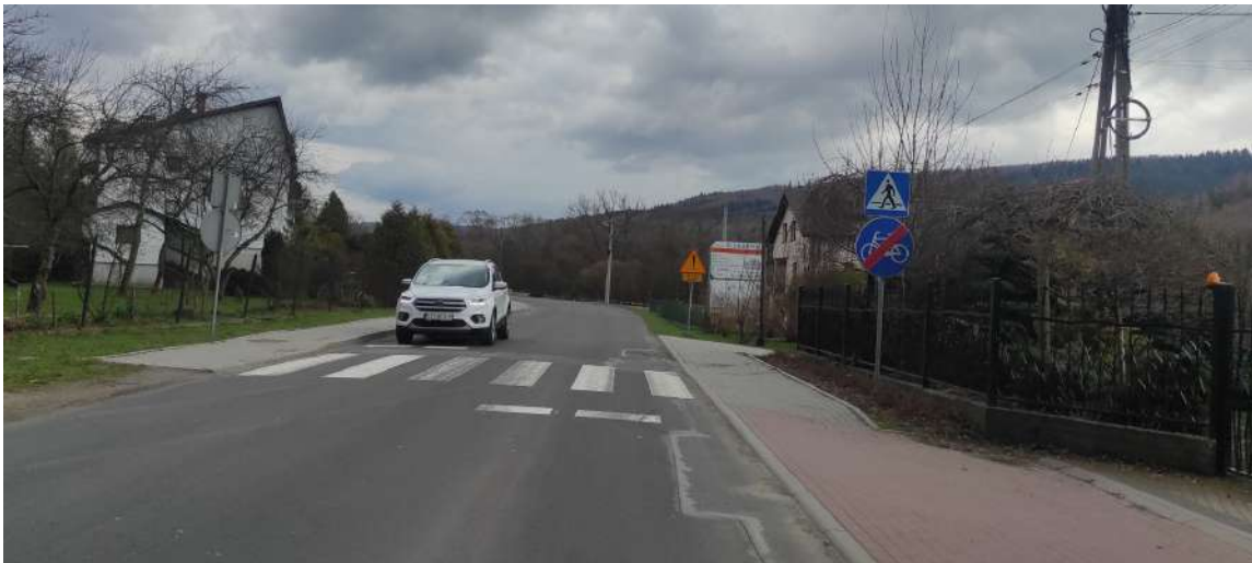
Rys. 27. Ciąg ul. Ujsolskiej w Rajczy i nieprawidłowo zaplanowana infrastruktura rowerowa. Ciąg należy przeznaczyć na chodnik, a ruch rowerowy prowadzić w jezdni z zastosowaniem elementów wpływających na poprawę BRD oraz uspokojenie ruchu.
