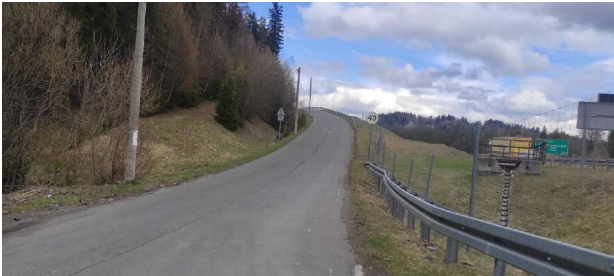
Rys. 20. Pochylenie jezdni na drodze serwisowej wzdłuż drogi ekspresowej S1, w rejonie osady Białożytkówka. Pochylenia przekraczające 6%, uniemożliwiają masowy turystyczny ruch rowerowy. Milówka.
