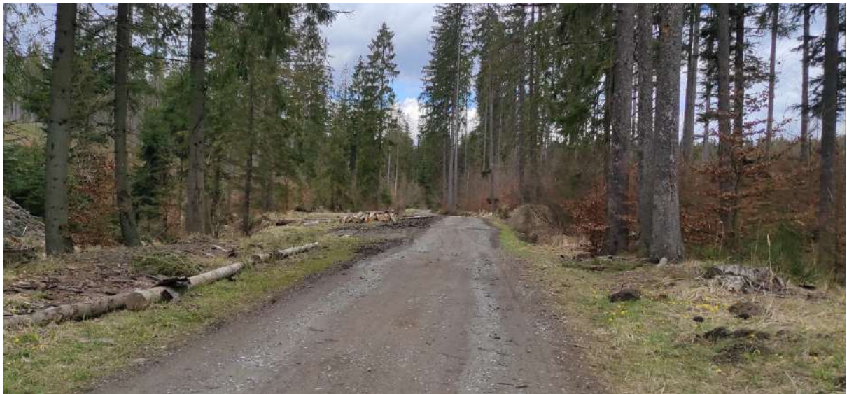
Rys. 22. Droga leśna (wewnętrzna) o nawierzchni tłuczniowej na terenie Nadleśnictwa Wiśla w Istebnej. Odcinek przeznaczony do remontu, poprzez wymianę nawierzchni na bitumiczną.
