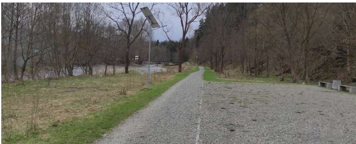
Rys. 28. Istniejąca infrastruktura rowerowa wzdłuż lewego brzegu rzeki Woda Ujsolska w rejonie ul. Granicznej. Nieprawidłowa nawierzchnia oraz szerokość ciągu pieszo-rowerowego, która powinna wynosić min. 3 m. Ujszoły.
