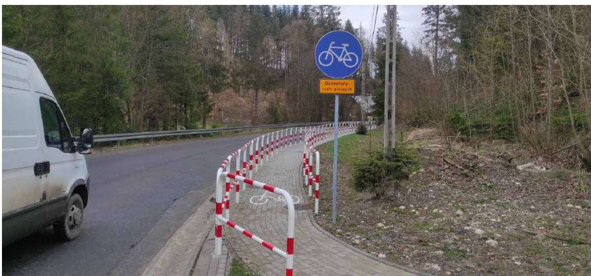
Rys. 31. Ul. Księdza Józefa Pułki w Ujsołach. Nieprawidłowo zaprojektowana infrastruktura rowerowa. Ciąg należy przeznaczyć na chodnik, a ruch rowerowy prowadzić w jezdni z zastosowaniem elementów wpływających na poprawę BRD oraz uspokojenie ruchu.
