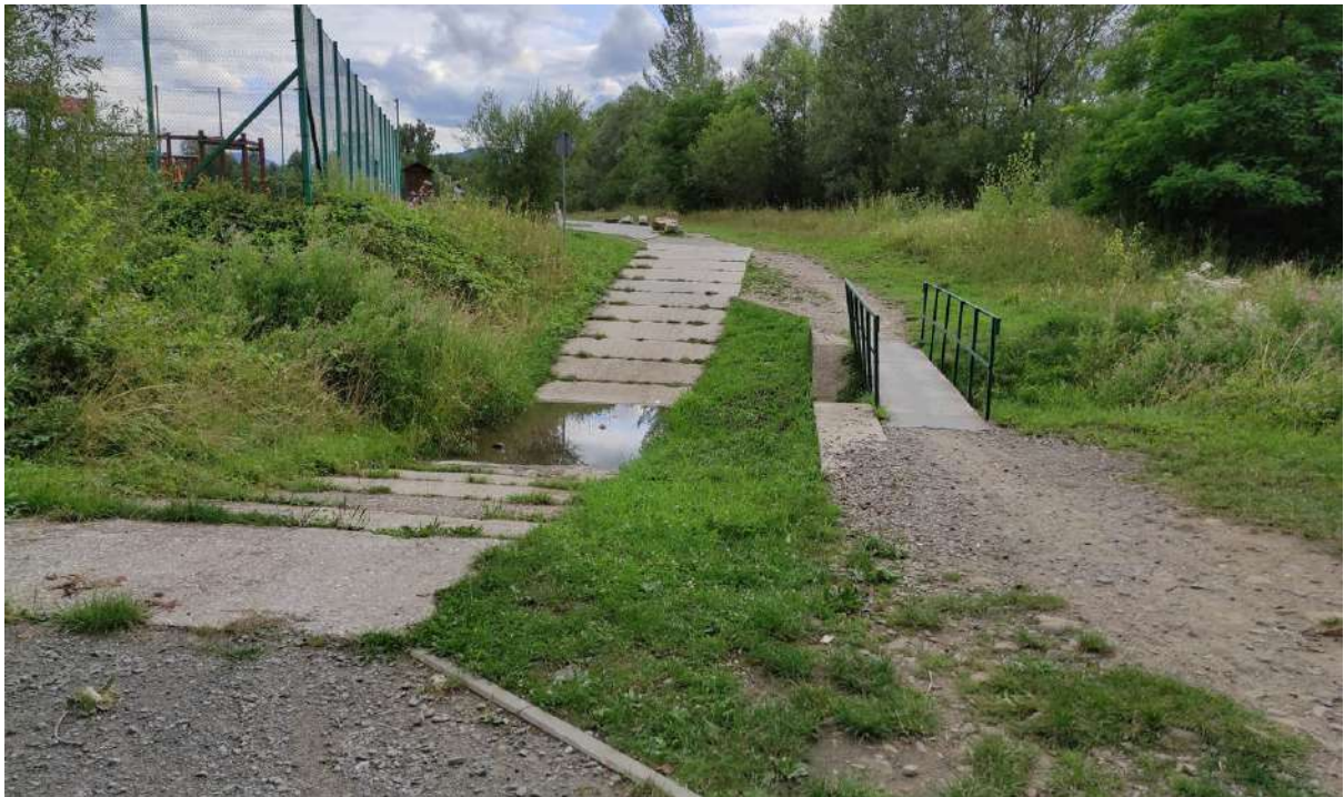
Rys. 15. W przebiegu istniejącego ciągu pieszo-rowerowy zlokalizowanego w rejonie cieku wodnego przy ul. Sportowej, należy wybudować kładkę lub przepust, poprawiając ciągłość infrastruktury rowerowej. Węgierska Górka.
