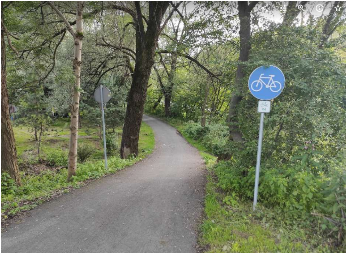
Rys. 4. Przykład wzorcowej nawierzchni bitumicznej (asfaltowej) w przebiegu planowanej trasy rowerowej nr 17 oraz 611 VeloSoła.. Rajcza.
