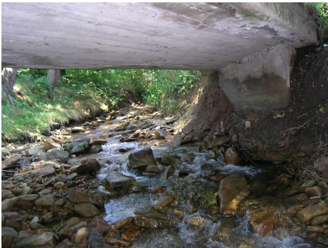
Zdjęcie nr 4 - Przyczółek mostowy, koryto potoku, płyta pomostowa
