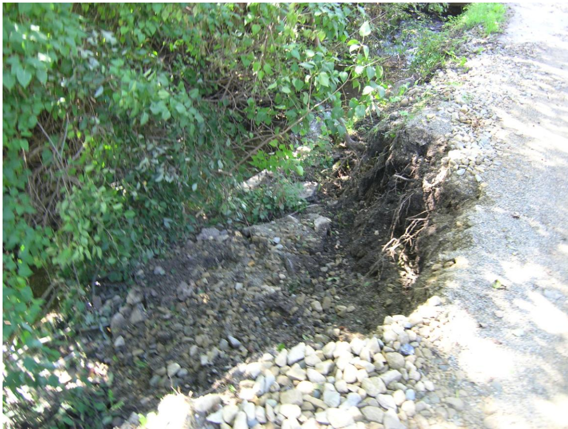
Zdjęcie nr 3 – Uszkodzenie korpusu drogi – obsunięcie istniejącego muru oporowego
